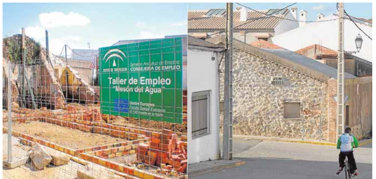
Las obras para rehabilitar el Mesón del Agua comenzaron en 2009 y seis años después siguen sin concluirse J.C.R.
